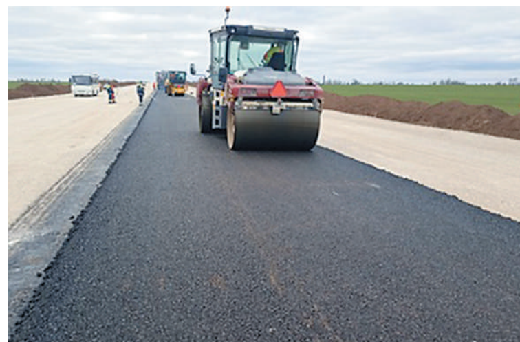
На втором этапе уже укладывают верхний слой основания асфальта. Всего их три.
